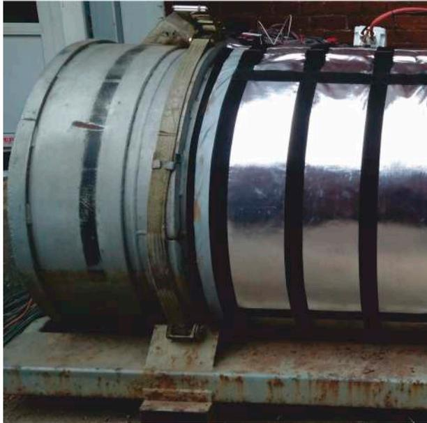
Электронагревательный чехол «Теплотек» взрывозащищенный соответствует определению из п. 3.17. ГОСТ 30852.8-2002 (является системой, состоящей из электрического нагревателя — питаемого от сети, проводов, прокладок, заливной массы, элементов контроля и регулирования температуры, предназначенной для повышения и поддержания температуры продуктов, содержащихся в резервуарах и сопряженном оборудовании, устанавливаемой снаружи).
